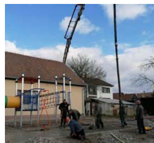
Beton réteg készítése
