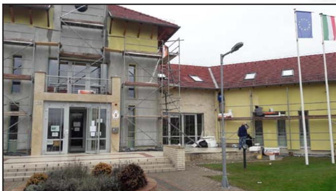
Faluház homlokzati munkái
