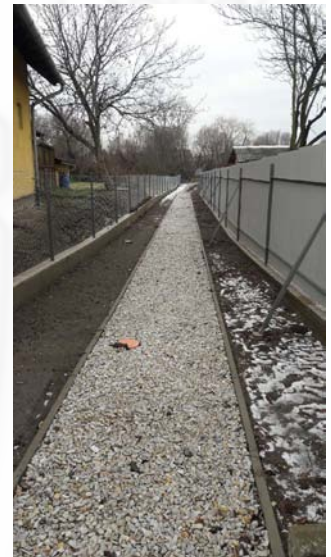
Elkészült a járda és a kerítés
