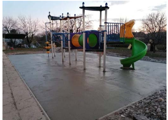
Jöhet a ragasztó és a gumilap. Beton alap
