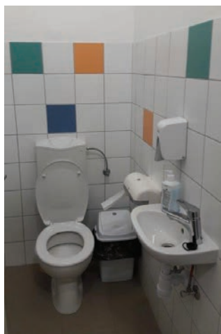
Felújított mosdó a tornatermi öltözőben
