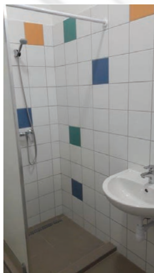
Felújított öltözői zuhanyzó
