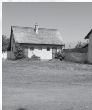
Felújításra szánt épület
