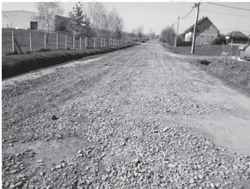
A kőszórásos módszertől nagyobb tartósságot remélünk
