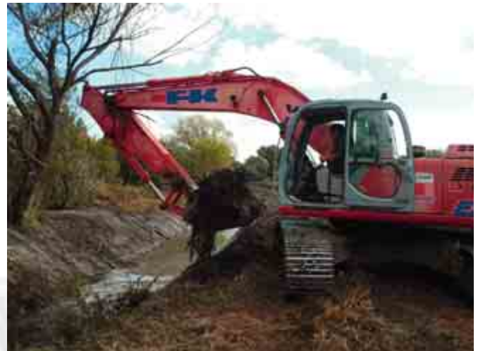
Kotrógép dolgozik a Tece-patak medrén
