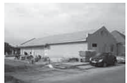
Épül a COOP áruház
