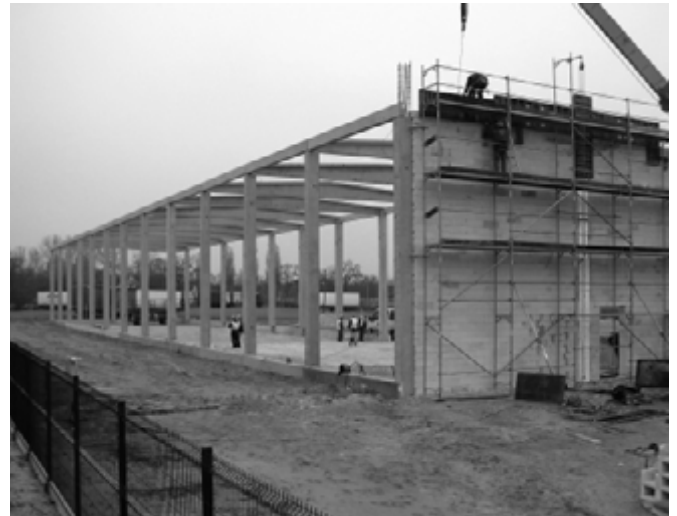
Csarnok épül a Fő út eddig beépítetlen oldalán
