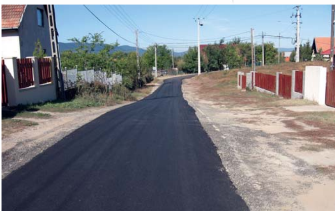
Új aszfaltút Neveleken
