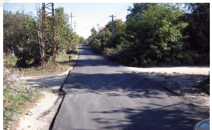
3740 m 2 aszfaltút épült Neveleken
