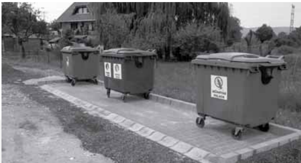
Viacolor burkolatot kaptak a szelektív hulladékgyűjtő-szigetek
