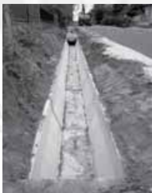
Ezután betonbéléses árokban fog elfolyni a csapadékvíz
