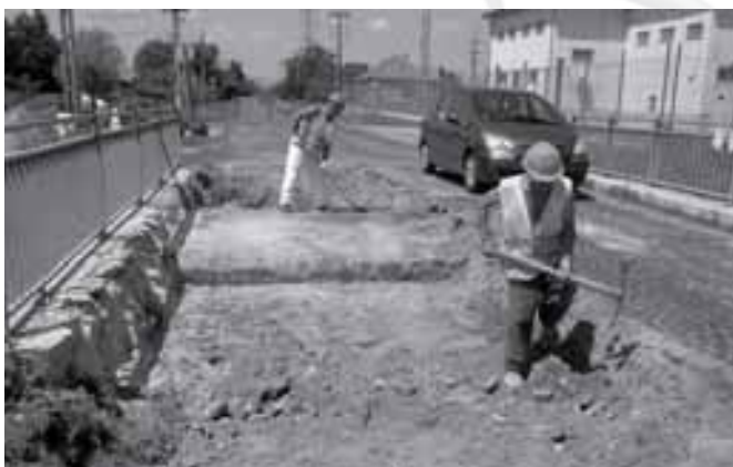
A híd szerkezete 1941-ben épült
