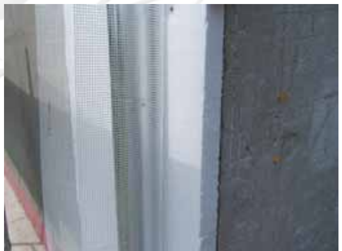
Készül a régi óvodaépület külső hőszigetelése
