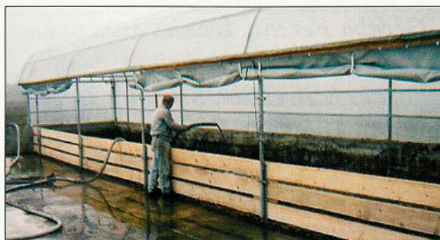
A szennyvíziszap-komposztáló megépítése (2004)
