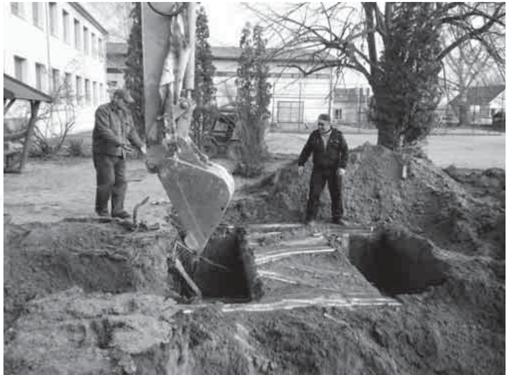
Balesetveszélyes régi szennyvízknák és kerítésalap fölszámolása az iskola udvarán
