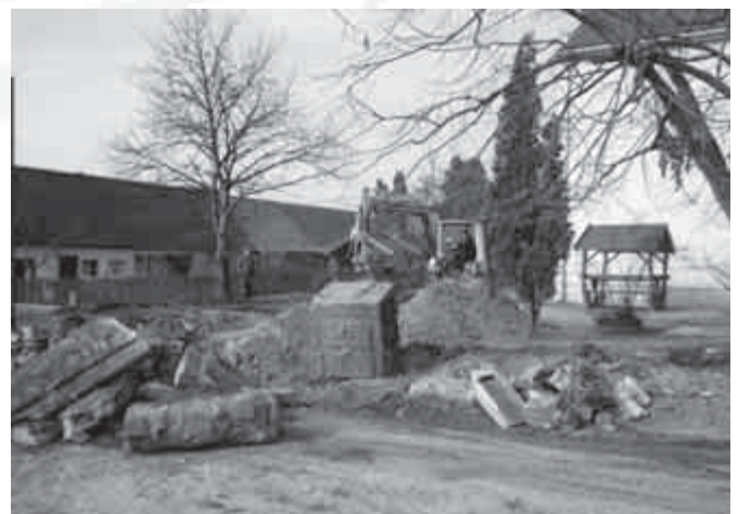
Balesetveszélyes régi szennyvízknák és kerítésalap fölszámolása az iskola udvarán
