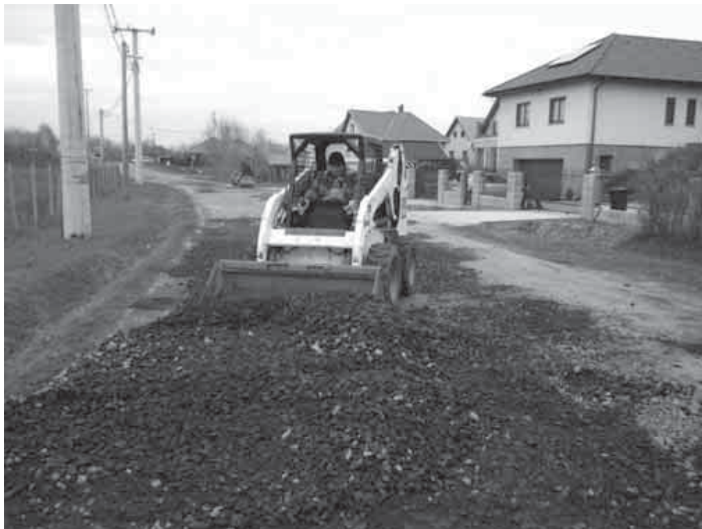
Köveket terít a kátyús úton egy helyi vállalkozás munkagépe
