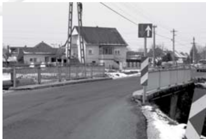
A szödi híd útszűkülete az átépítéssel meg fog szűnni
