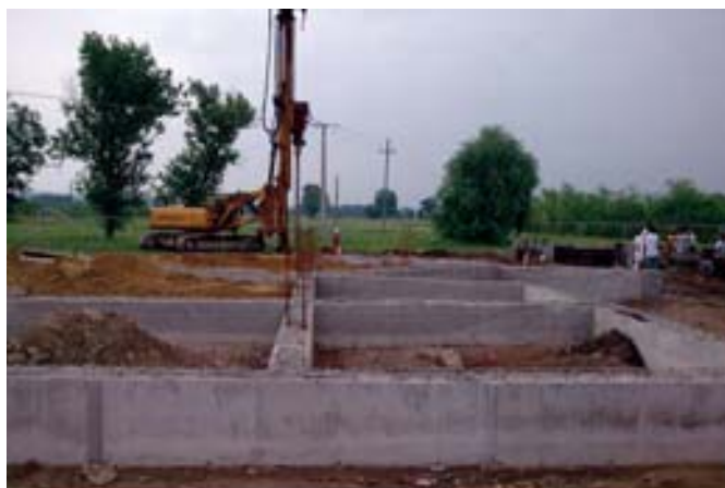
A kulturális központ alapozási munkálatai
