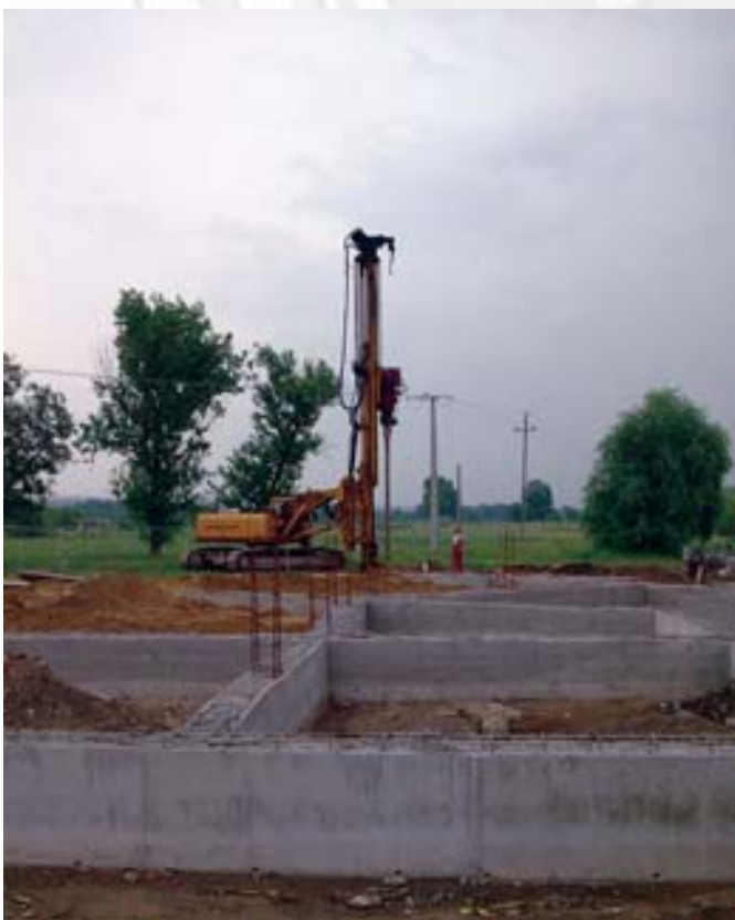
A töltött területen több száz cölöp került a talajba
