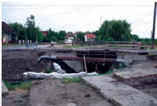
A Sződrákos-patak hídjának átépítése
