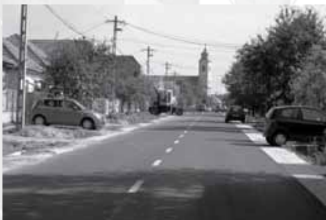
Az új úttest, reméljük, sokáig fogja szolgálni a közlekedést!
