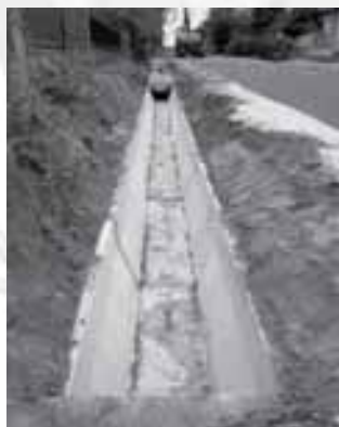
Ezután betonbélelés árokban fog elfolyni a csapadékvíz
