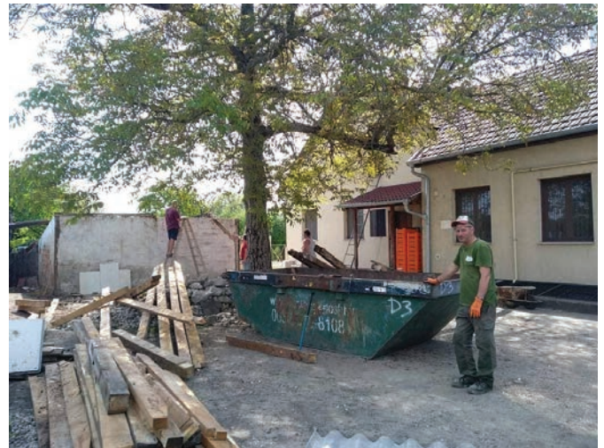
A régi tároló felújítása
