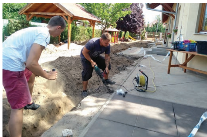
Öntözőrendszer nyomvonalának kialakítása
