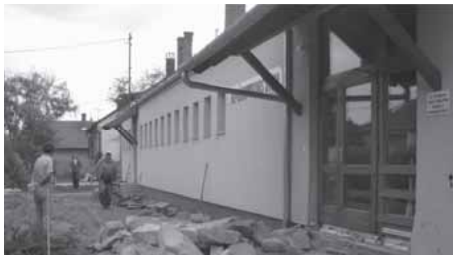
Megindult az óvodai építkezés
