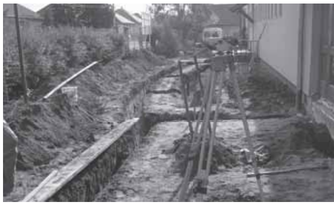
Megindult az óvodai építkezés
