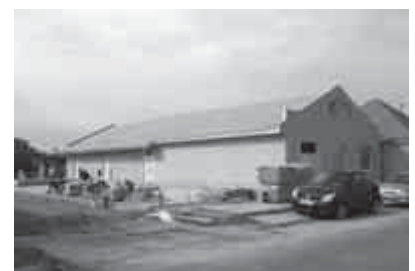
Épül a COOP áruház
