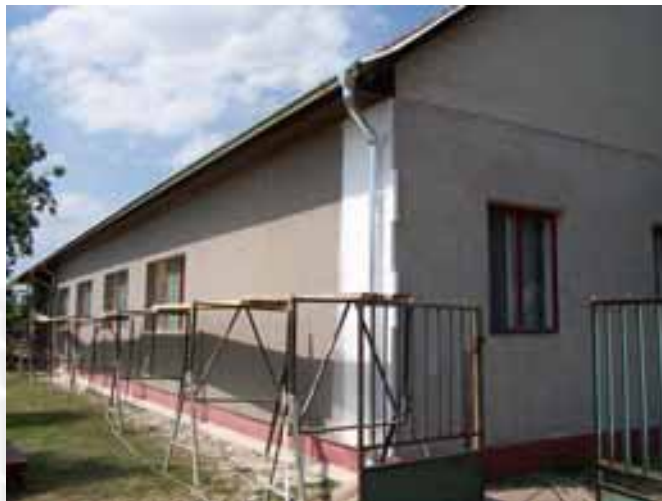
Készül a régi óvodaépület külső hőszigetelése
