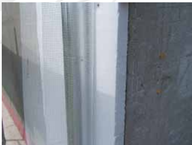
Készül a régi óvodaépület külső hőszigetelése
