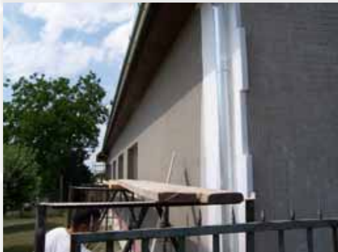
Készül a régi óvodaépület külső hőszigetelése
